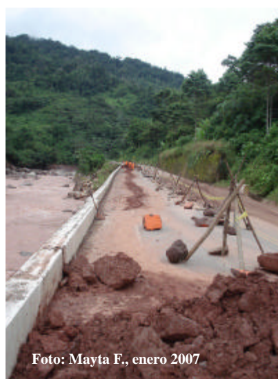
FotoN°7.5 Carretera Federico Basadre, Progresiva Km 413+600, Sector Juan Velasco, la erosión fluvial esta incidiendo en la margen izquierda y esta afectando a la carpeta asfáltica (provincia y distrito PadreAbad).
